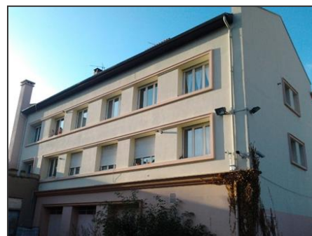
Le bâtiment avant rénovation
