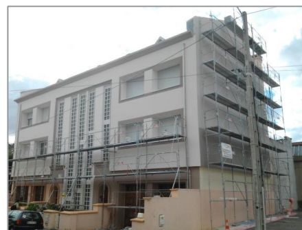
Le bâtiment après rénovation
