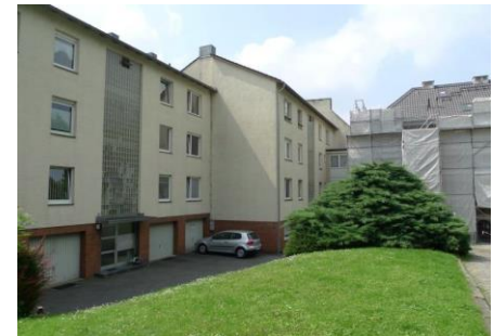
Seitenansicht der Gebäude
