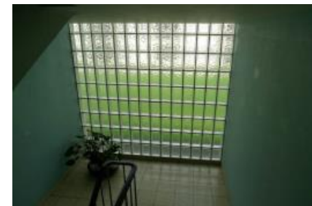
Glasbausteine im Treppenhausbereich
